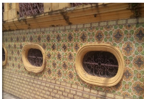
Figura 8. Parede do Palacete Pinho
